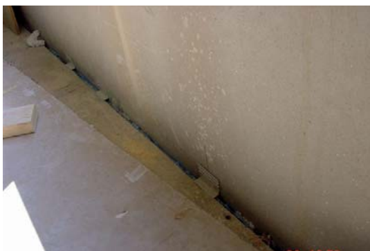
3. Een besparing in de werkvloer waarin kabels worden gewerkt.
